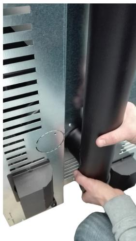
Fig. 55 - Innestare tubo d.80 mm
