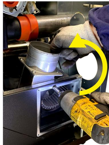
**Fig. 63 - Ruotare ventilatore**
