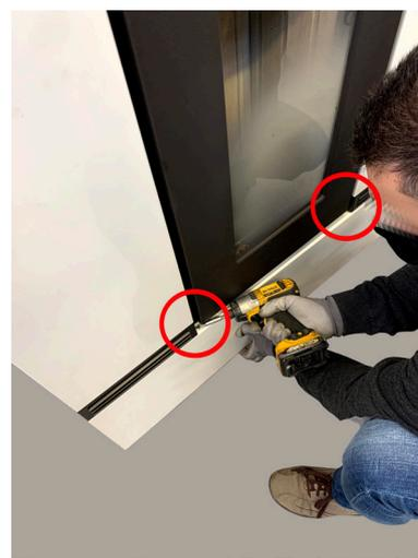
**Fig. 44 - Fissare pannello inferiore**
