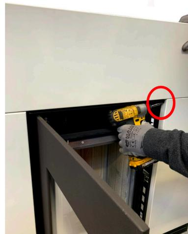
**Fig. 41 - Fissare pannello superiore**
