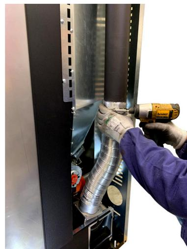
**Fig. 66 - Fissare i tubi**
